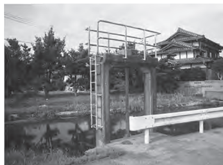
▲平成27年度適正化事業で整備予定のゲート
