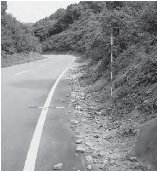
イノシシがのり面を崩し危険な状況
