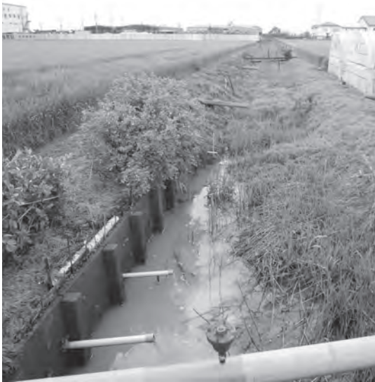
県営クリーク防災事業外の農業用水路の様子
