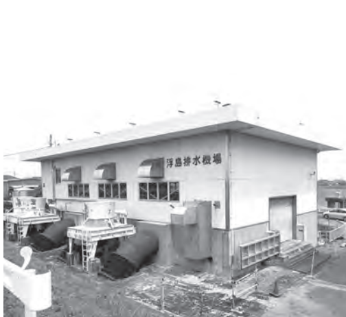
老朽化した浮島排水機場
