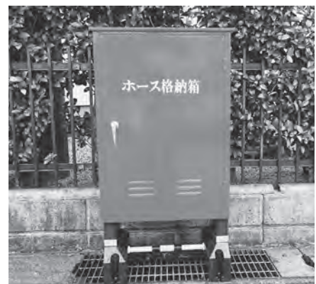
消防ホース格納箱
