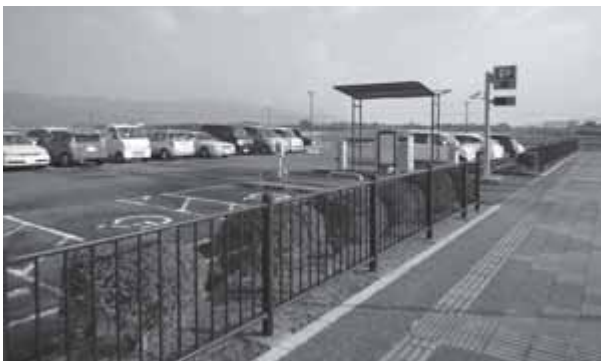
神崎市駅北口駐車場
