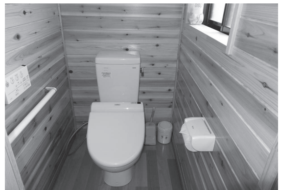
トイレ洋式化の改修箇所
