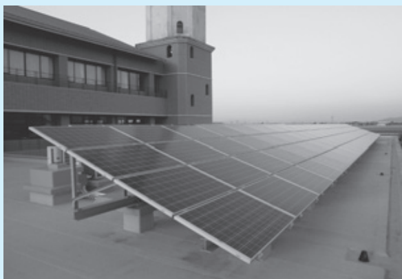
▲千代田支所太陽光パネル
